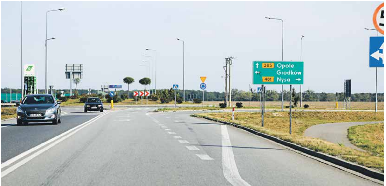
Na skrzyżowaniu obwodnicy Grodkowa z drogą 385 zamontowano już oświetlenie
