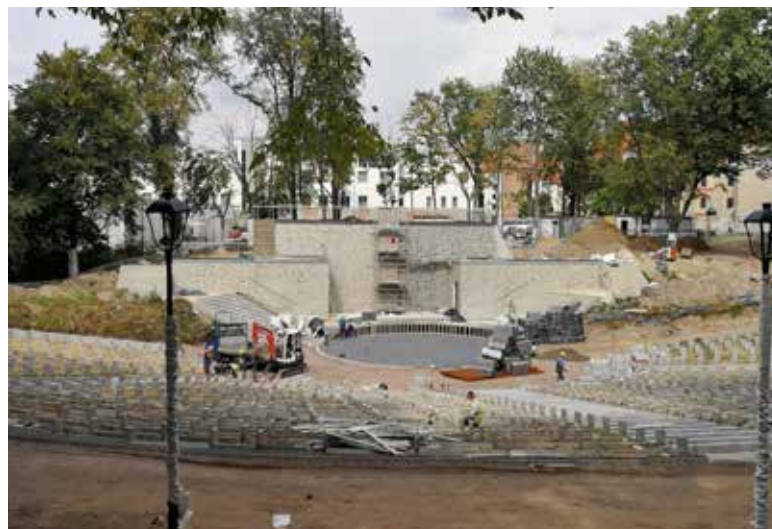
Prace w brzeskim amfiteatrze trwają
