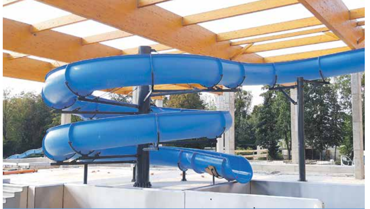
Basenowa zjeżdżalnia jest już zamontowana Fot. UM Kędzierzyn-Koźle
