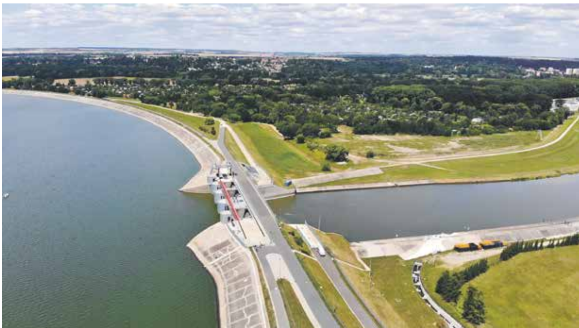
Modernizacja zbiornika nyskiego kosztowała niemal 500 milionów złotych
