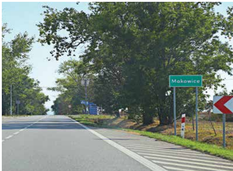
Droga wojewódzka nr 401 została już przez władze regionu kompleksowo zmodernizowana
