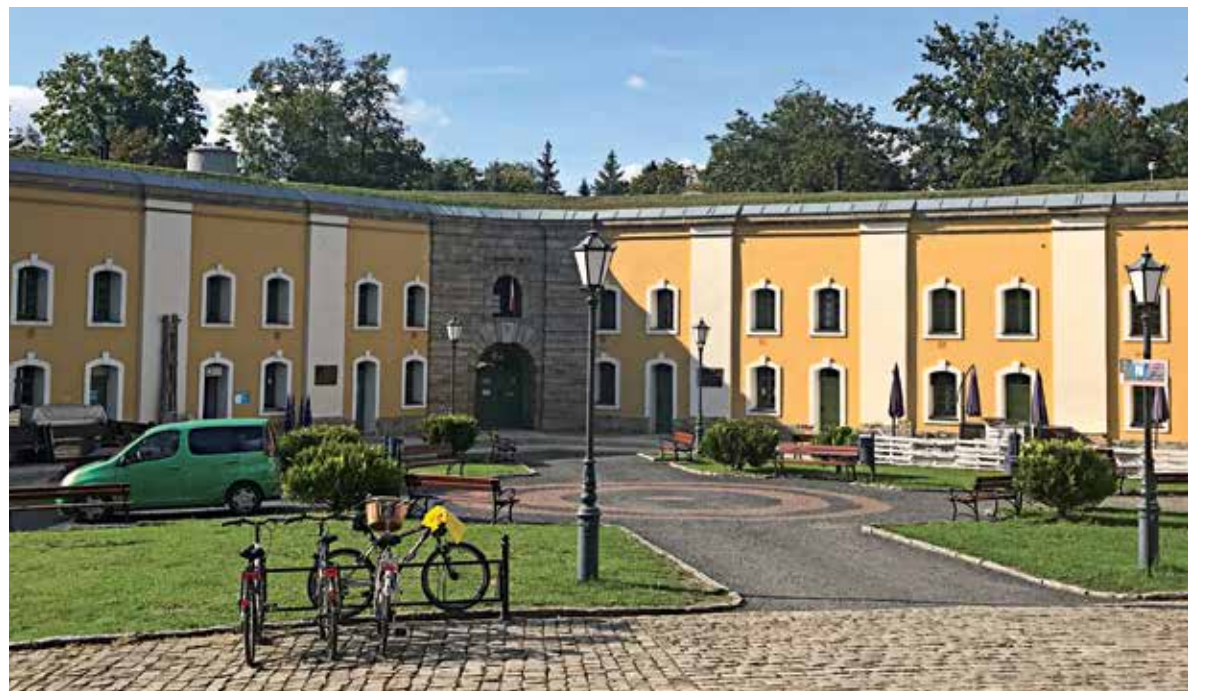
Bastion Świętej Jadwigi jest dziś atrakcją turystyczną także dzięki dotacjom z UE
