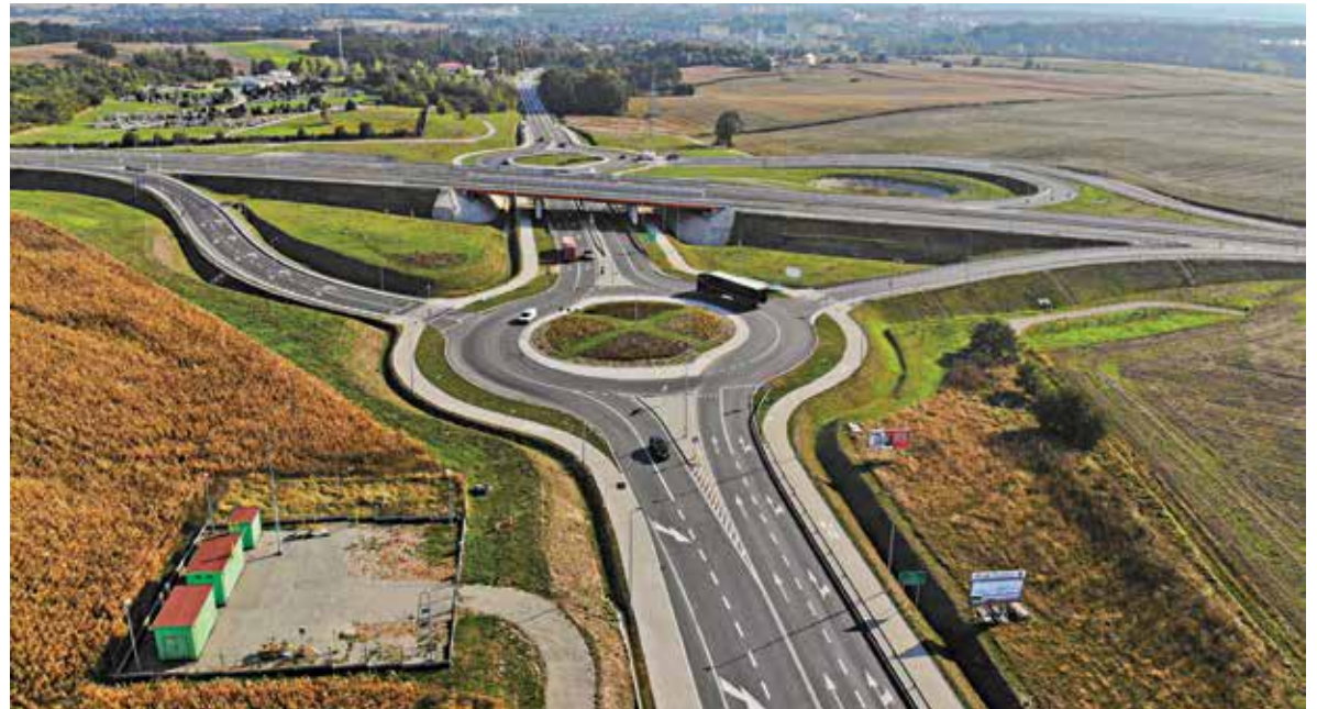
Obwodnica Nysy to 16,5 kilometra, czternaście mostów, cztery ronda i węzeł drogowy
