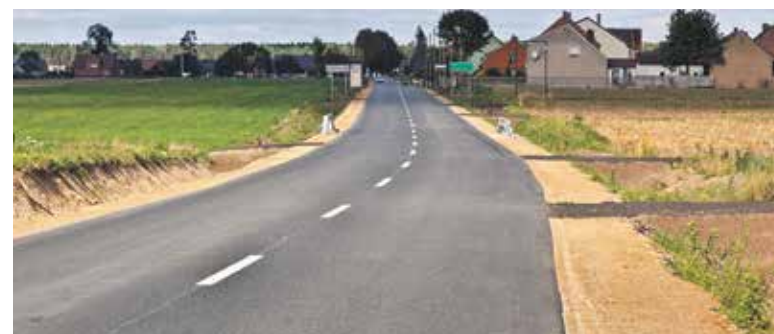
Nowa nawierzchnia drogi w Ligocie Turawskiej
