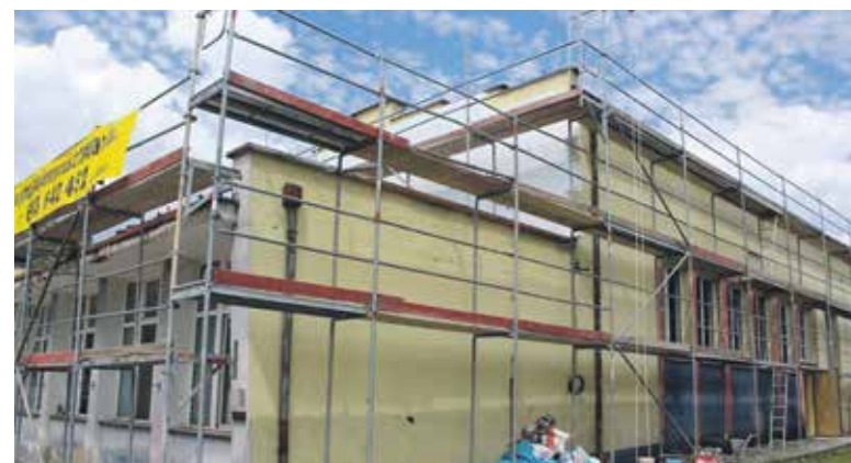
Świetlica w Żelaznej jest właśnie remontowana Fot. UG Dąbrowa
