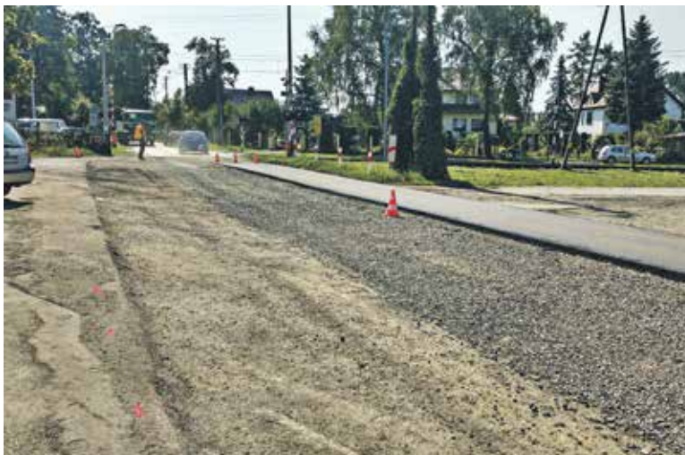
W Suchym Borze budowa już trwa
