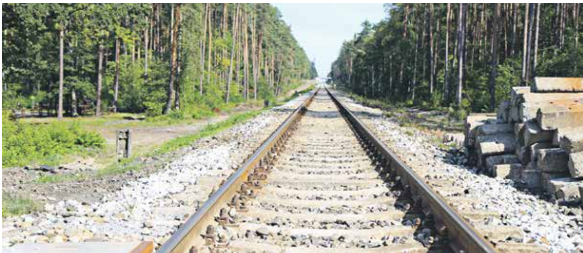
To już nowe tory, po których zdecydowanie szybciej pojedziemy z Opola do Nysy
