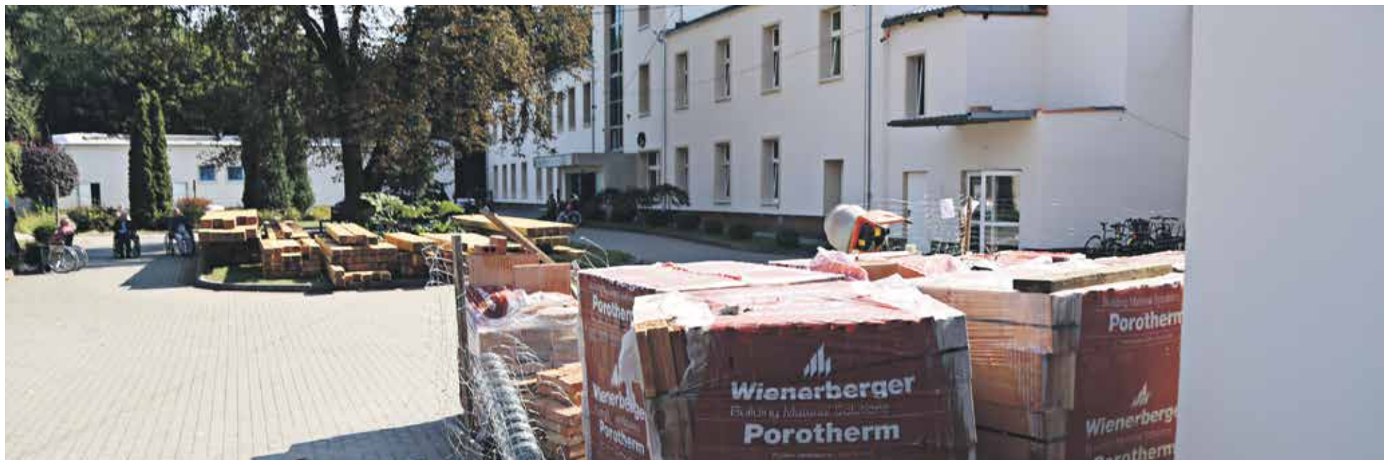
Remont w niemodlińskim Zakładzie Opieki Zdrowotnej trwa
