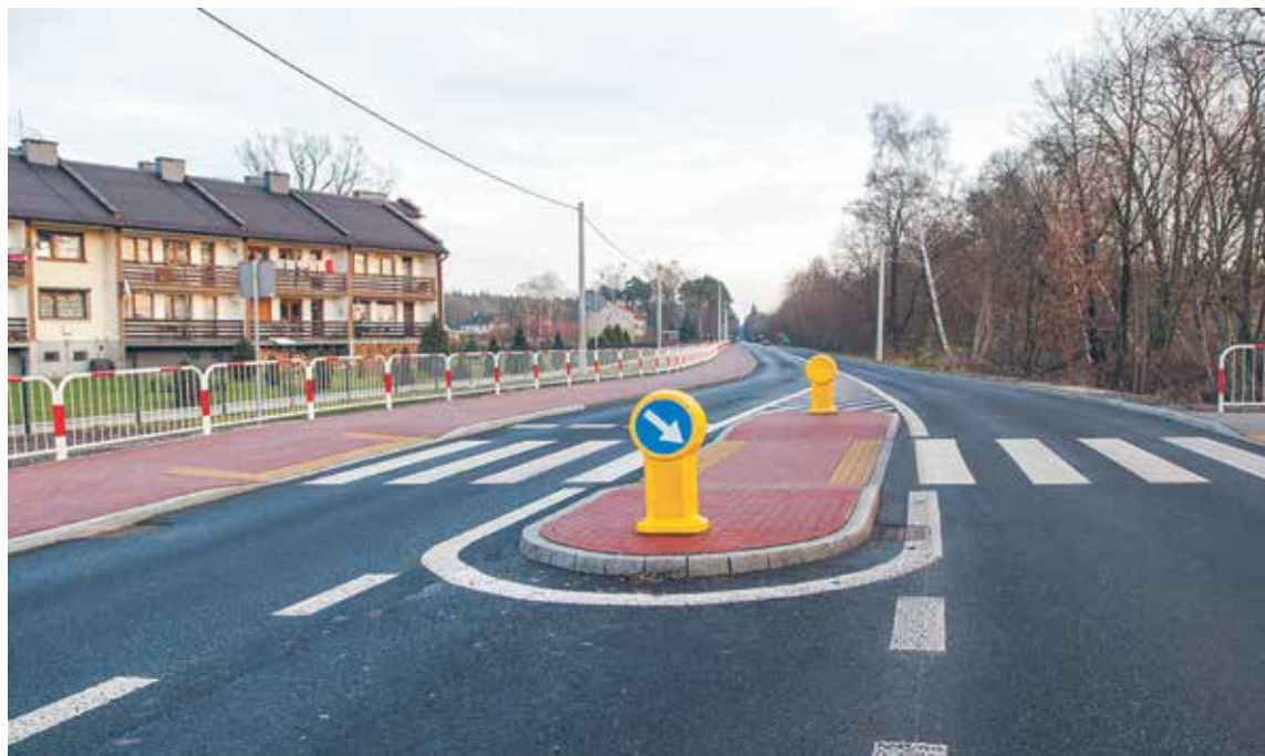
Poprawa bezpieczeństwa pieszych była jednym z najważniejszych celów przebudowy drogi 463.
