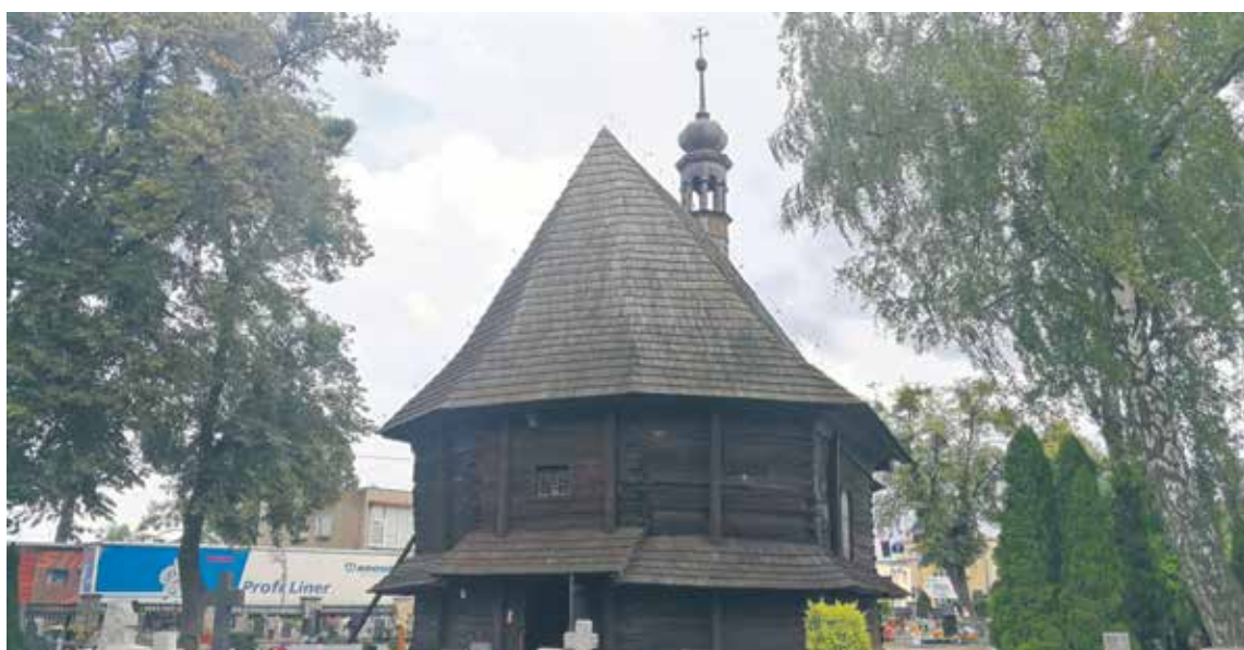
Remont strzeleckiego drewnianego kościoła jest niezbędny, a szczególnie ważne jest jego zabezpieczenie
