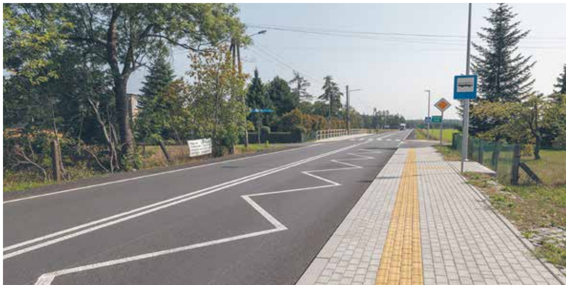
To kolejny odcinek drogi nr 901, który jest już przebudowany
