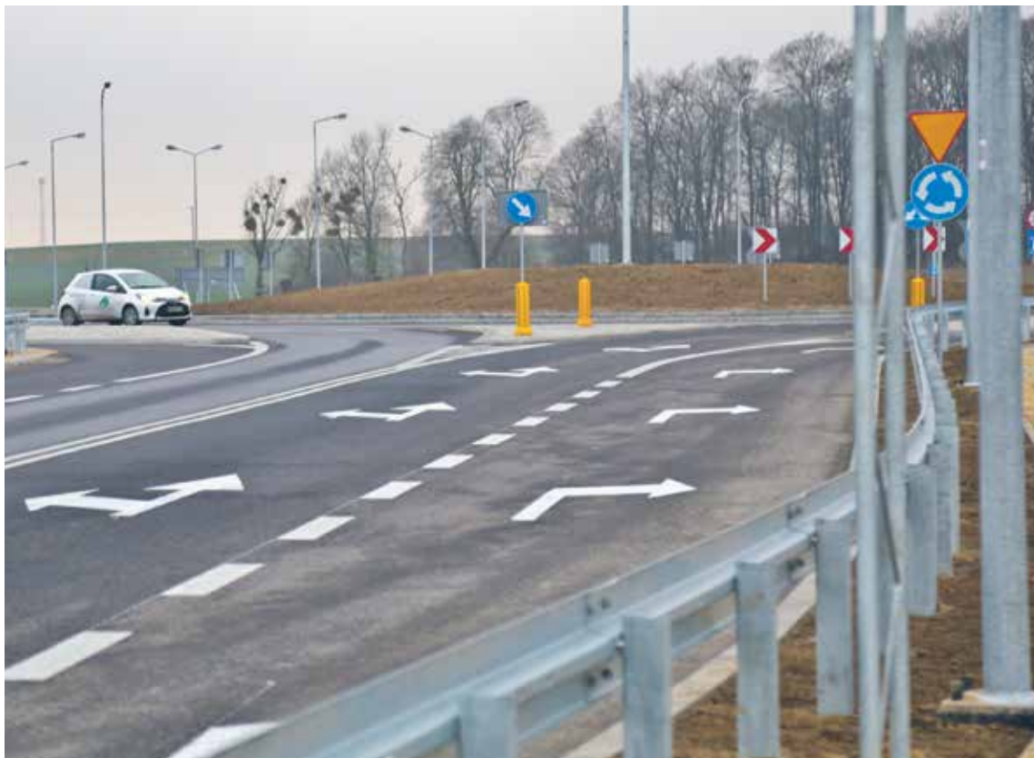
Rondo przy węźle autostradowym w Olszowej znacząco ułatwiło dojazd do autostrady A4
