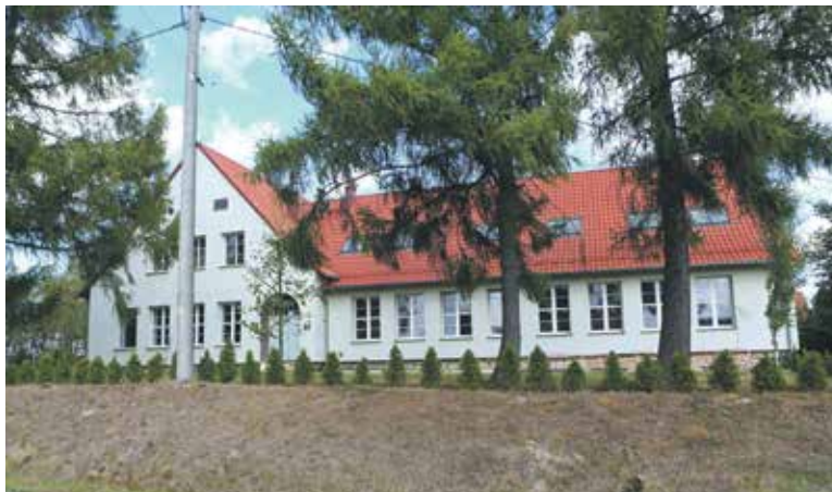
Budynek z zewnątrz wygląda już ładnie, teraz intensywne prace prowadzone są wewnątrz
